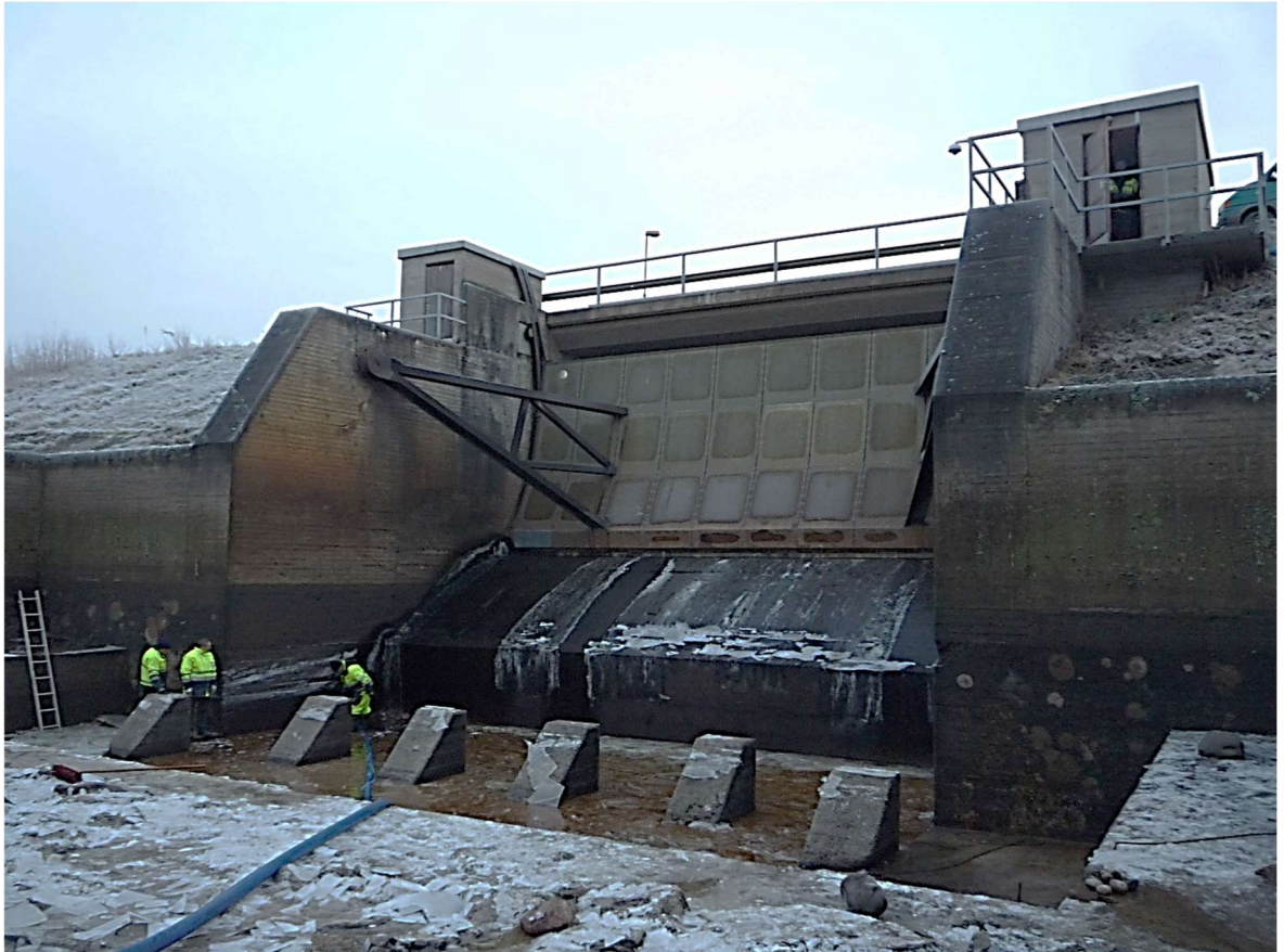
Kuva 3. Sääkskosken säännöstelypato ja sen kuivaksi otettu vaimennusallas Kruunupyssä 21.11.2013.
