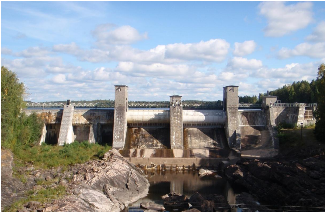
Kuva 2: Imatrankosken voimalaitospato (Kuva: Milla Saarinen)
