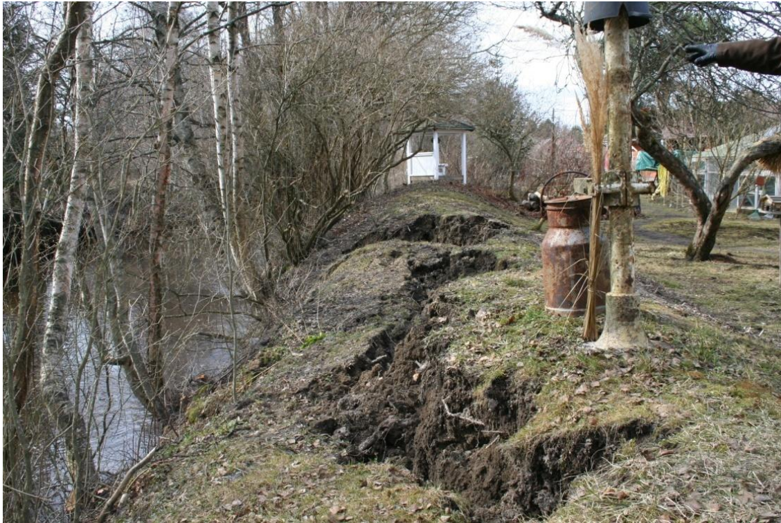
Kuva 8: Murtunut tulvapenger Harjunpäänjoen rannalla (Taina Rusola)
