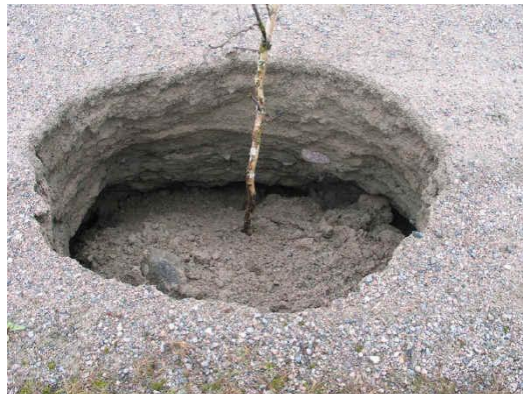
Kuva 7: Pamilon voimalaitoksen maapatoon 7 syntynyt onkalo. (Kuva: Hannu Ruotsalainen, Vattenfall Sähköntuotanto Oy)
