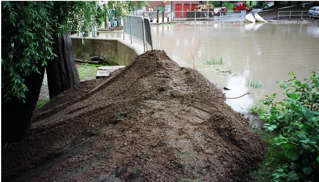
Kuva 4: Kellokosken pato ja soralla vahvistettu osa maapadosta heinäkuussa vuonna 2004. (Kuva: Mikko Sulkakoski)
