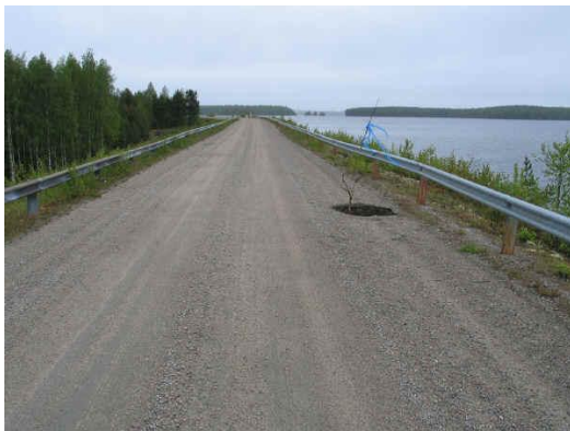
Kuva 7: Pamilon voimalaitoksen maapatoon 7 syntynyt onkalo. (Kuva: Hannu Ruotsalainen, Vattenfall Sähköntuotanto Oy)
