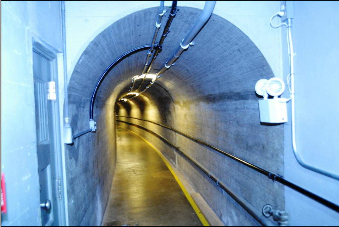
Kuva 35. Muun muassa halkeamien paikallistamiseen käytetty tarkastuskäytävä Hooverin padolla Arizonassa, Yhdysvalloissa. Toistaiseksi vain harmittomia hiushalkeamia on löydetty. [58]
