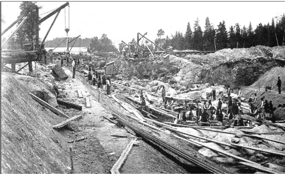
Kuva 3. Taipaleen kanavatyömaa Varkaudessa vuonna 1868. [13]
