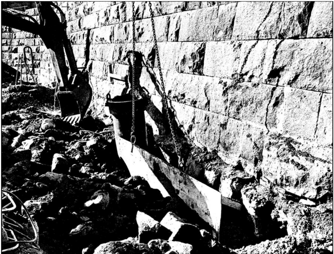
Kuva 49. Tiivistysseinän tekoa alkuperäisen luonnonkivimuurin alle.
