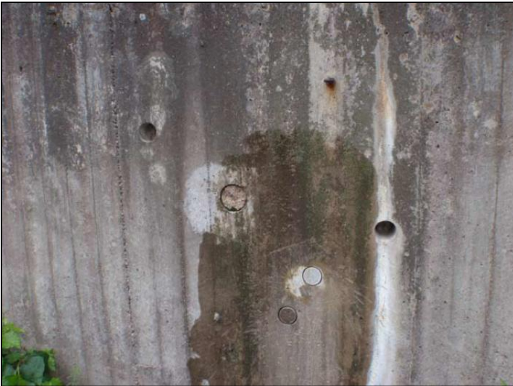
Kuva 56. Betonin vetolujuus- ja karbonatisoitumisnäytteiden ottokohta vuoden 2011 tutkimuksessa. [56]
