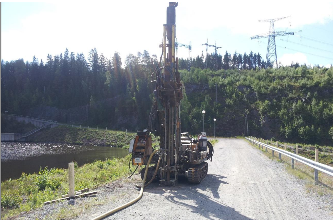
Kuva 58. Tiivistysinjektointia Melon voimalaitospadolla kesällä 2012.
