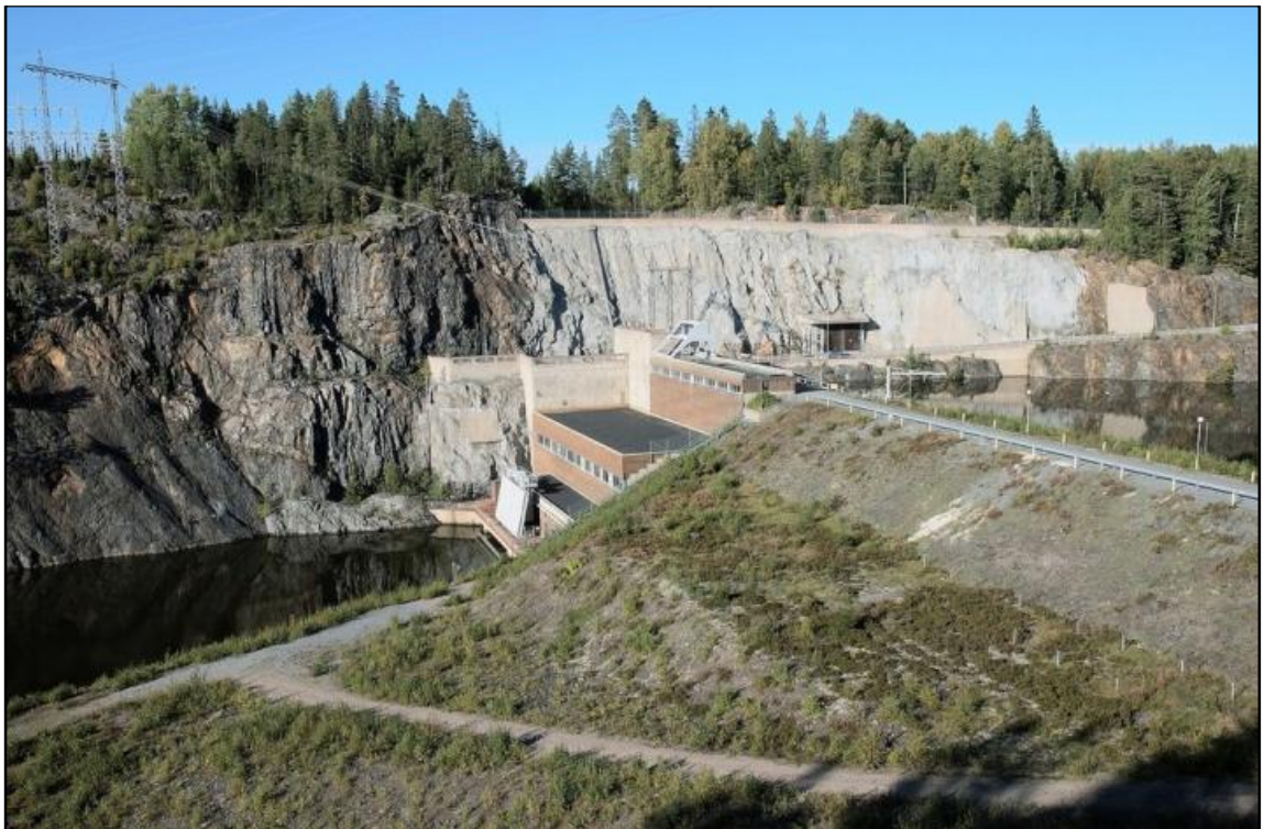
Kuva 37. Melon voimalaitospato etelän suunnasta kuvattuna. (Kuva: Juha Hurme)
