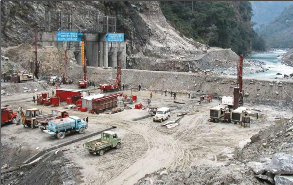
Kuva 60. Suihkuinjektointia Teestan patotyömaalla Intiassa. Menetelmällä rakennetaan kallioon ulottuva 40-metrinen vesitiivis katkaisuseinä. [65]
