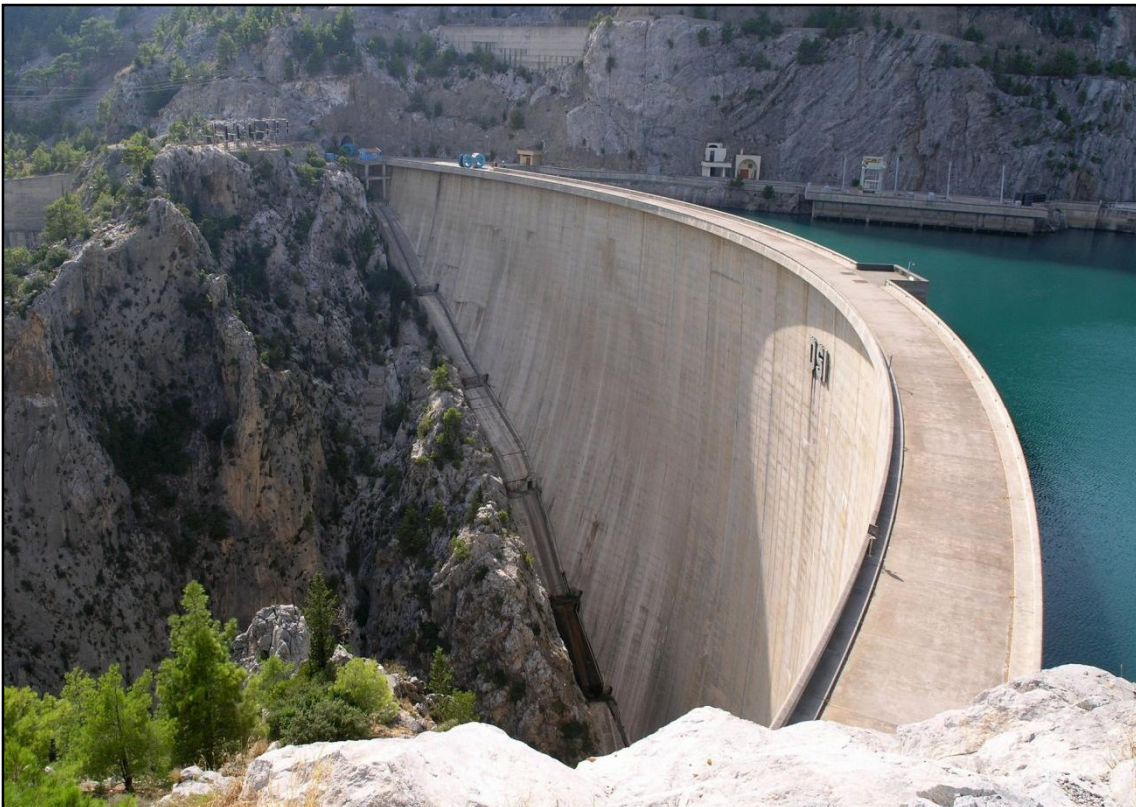
Kuva 21. Manavgatin holvipato Turkissa. Kuvassa holvipadolle tyypillinen, jyrkkäreunainen patopaikka. [59]
