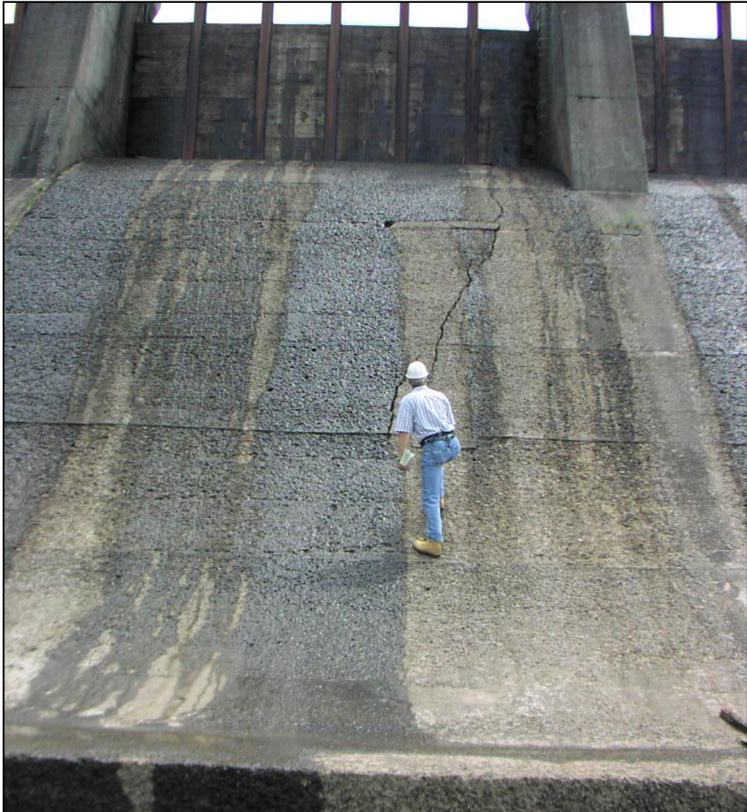
Kuva 34. Betonipadon silmämääräistä tarkastamista Yhdysvalloissa. [57]
