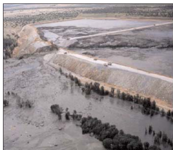
Los Frailes, Espanja (1998) Suuri tiheys (4000 kg/m 3 ), pohjan murtuma. McLeod et al, 2003
